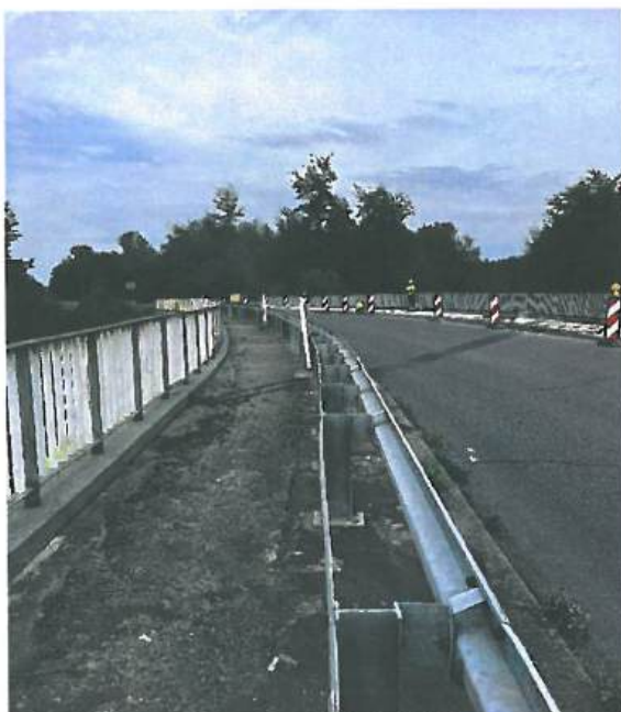
Fot. nr 10.5.1 Remont nawierzchni chodników mostu w ciągu DP nr 2071K Łąka Górna – Łapanów w miejscowości Tarnawa
