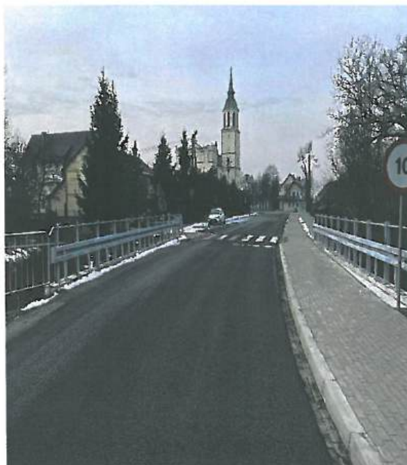
Fot. 5.6.2. Odcinek drogi powiatowej nr 2094K po rozbudowie drogi w miejscowości Okulice
