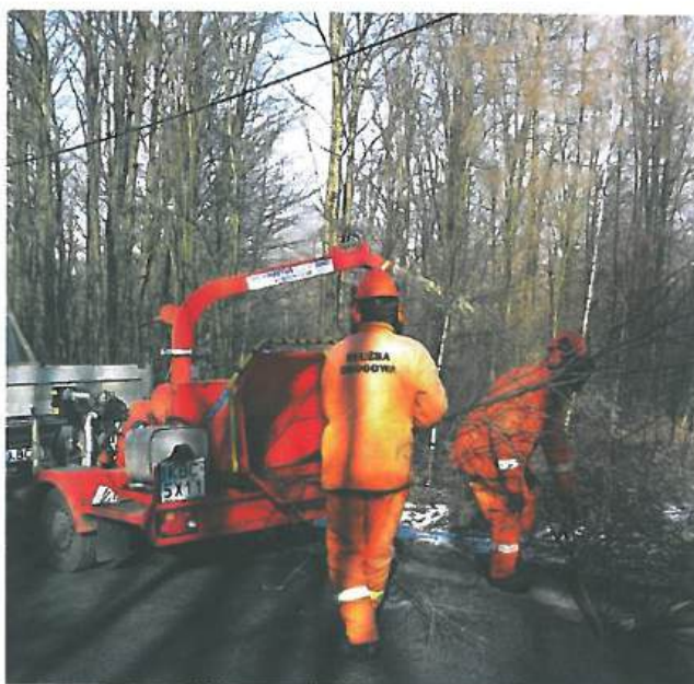
Fot. nr 10.11.2 Prace porządkowe
