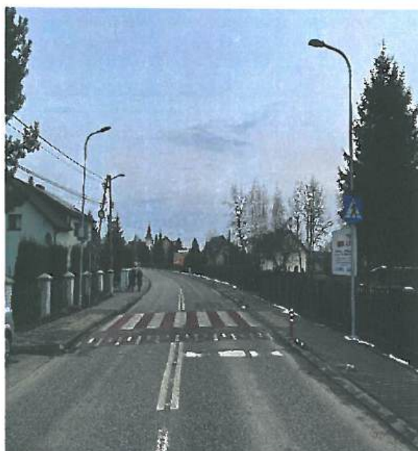
Fot. 5.11.2 Odcinek drogi powiatowej nr 1428K po wykonaniu przebudowy w miejscowości Krzczów
