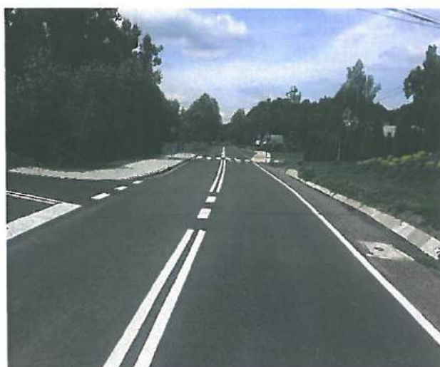
Fot. nr 5.1.2 Odcinek drogi powiatowej nr 2095K po rozbudowie drogi w miejscowości Trzciana
