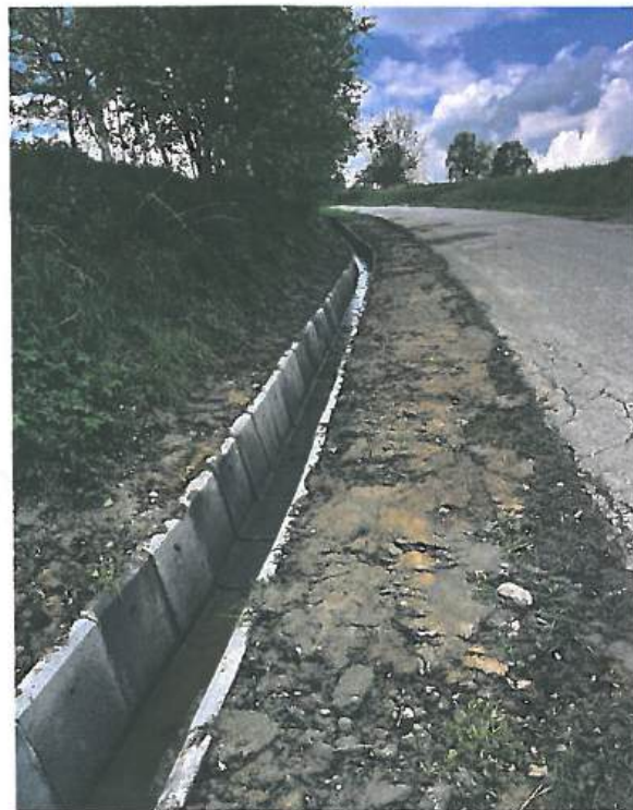
Fot. 10.6.2 Wykonanie umocnienia rowu przy DP nr 1447K w miejscowości Rajbrot
