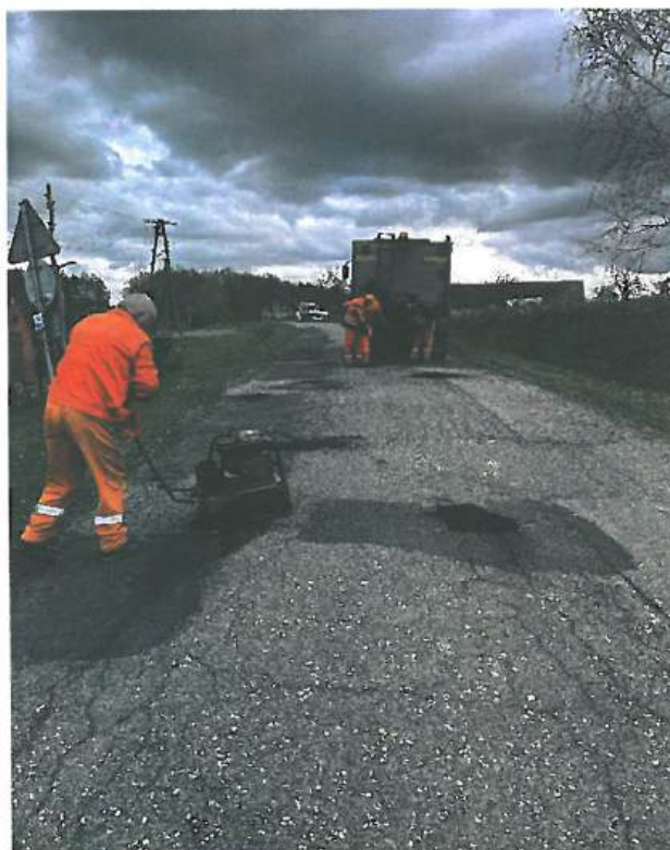
Fot. nr 10.11.4 Prace przy bieżącym utrzymaniu dróg powiatowych
