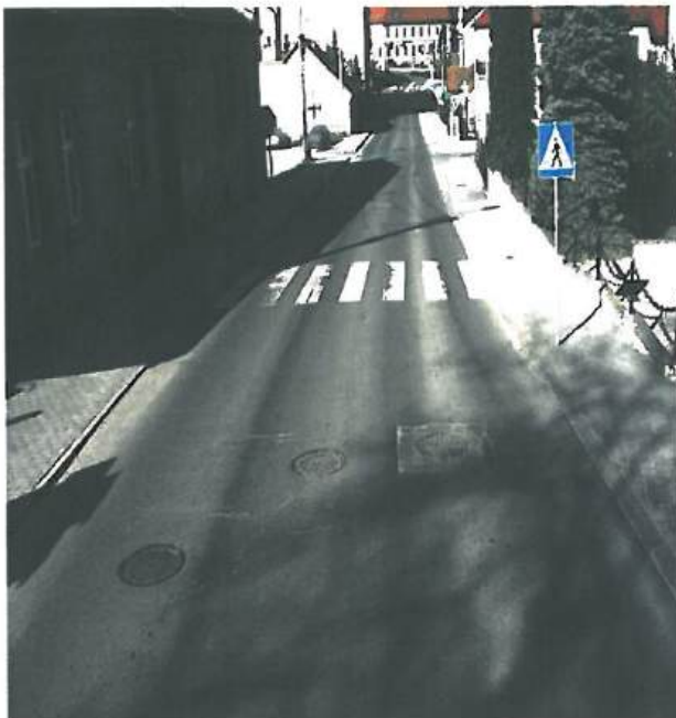
Fot. 5.10.1 Odcinek drogi powiatowej nr 1443K przed przebudową drogi w miejscowości Bochnia
