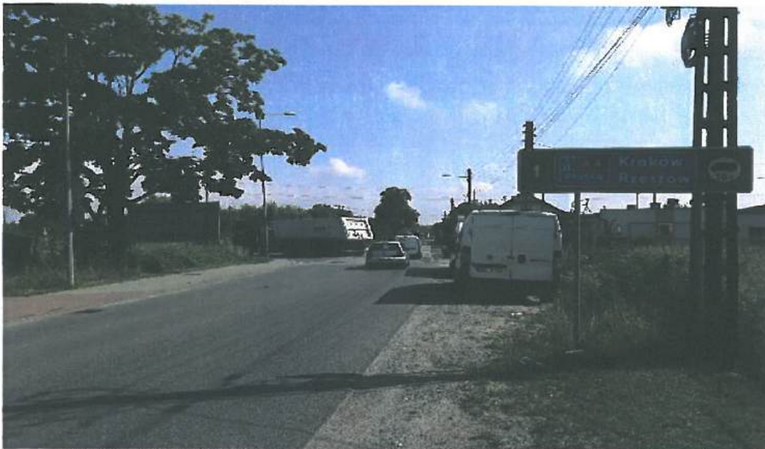
Fot. nr 5.2.1 Odcinek drogi powiatowej nr 1428K przed rozbudową drogi w miejscowości Bochnia
