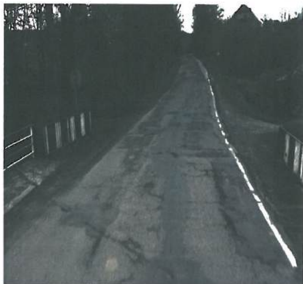
Fot. 10.2.1 Odcinek drogi powiatowej nr 2072K przed remontem w miejscowości Kamionna
