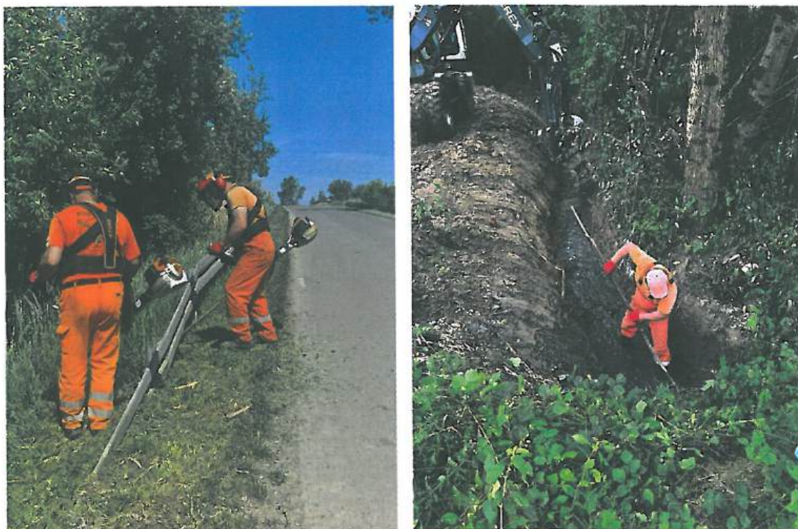
Fot. nr 10.11.3 Prace przy bieżącym utrzymaniu dróg powiatowych
