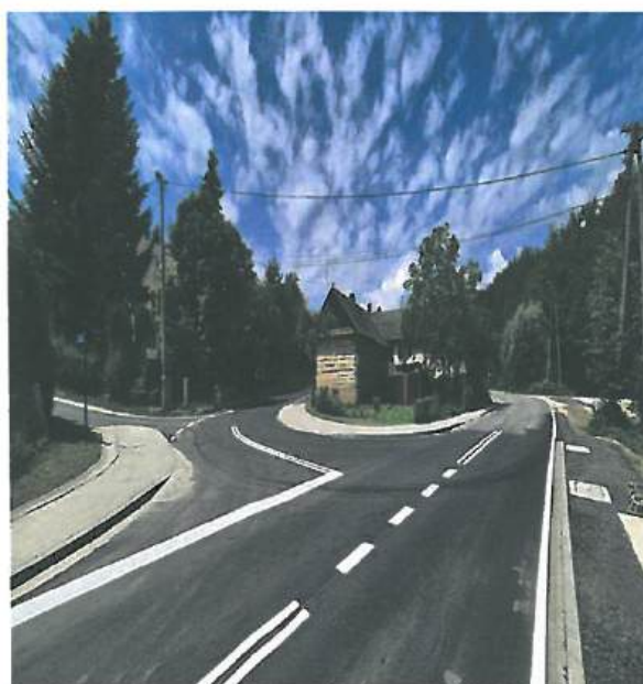
Fot. 5.8.2. Odcinek drogi powiatowej nr 1443K po rozbudowie drogi w miejscowości Bochnia
