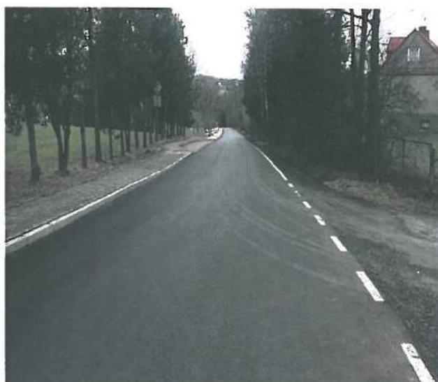
Fot. nr 5.3.4 Odcinek drogi powiatowej nr 2072K po przebudowie drogi w miejscowości Kamionna
