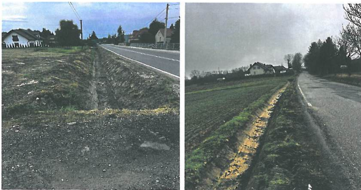
Fot. nr 10.8.1 Odmulone i udrożnione rowy drogowe
