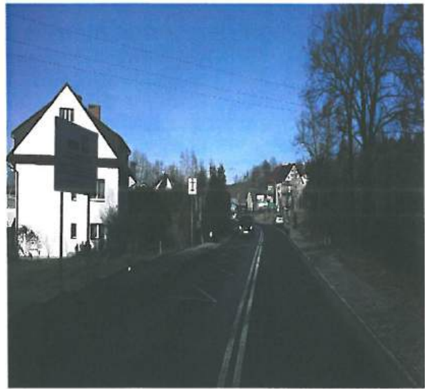
Fot. nr 5.3.2 Odcinek drogi powiatowej nr 2095K po rozbudowie drogi w miejscowości Trzciana
