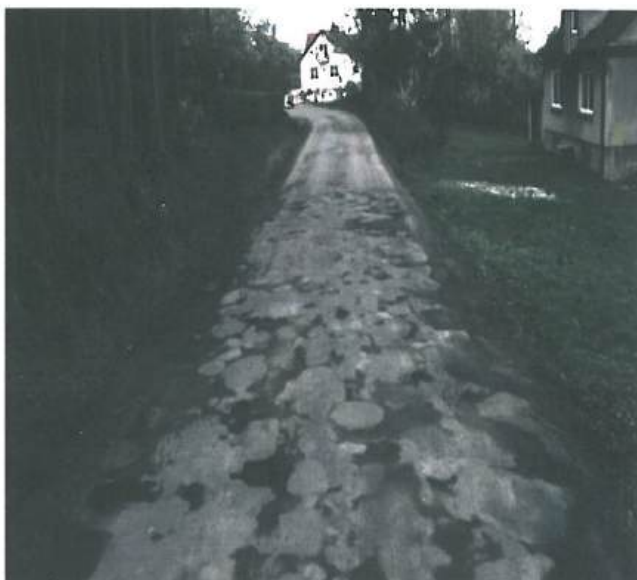
Fot.5.12.1 Odcinek drogi powiatowej nr 2071K przed przebudową drogi w miejscowości Ujazd
