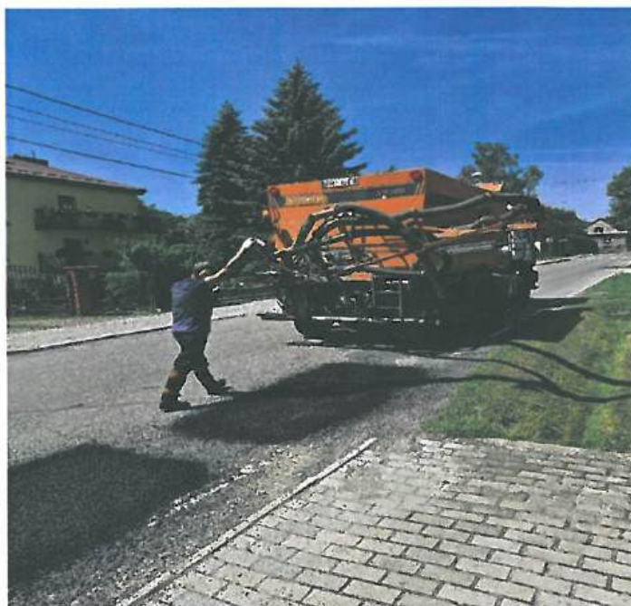
Fot. nr 10.3.1 Remonty częściowe nawierzchni bitumicznych mieszanką asfaltową z grysem
