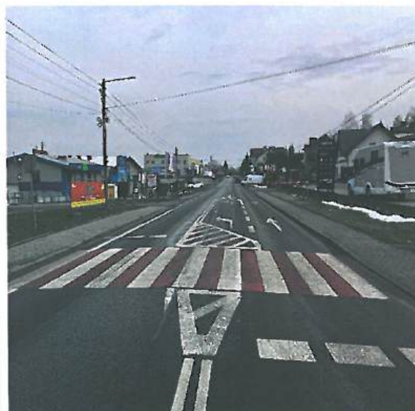
Fot. 10.1.2 Odcinek drogi powiatowej nr 1428K po wykonaniu remontu w miejscowości Bochnia
