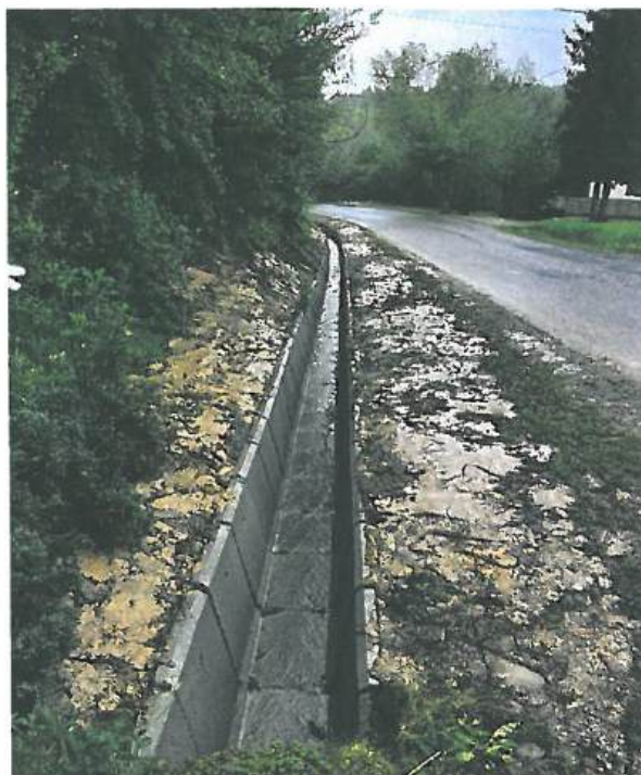
Fot. 10.6.1 Wykonanie umocnienia rowu przy DP nr 2017K w miejscowości Kobylec
