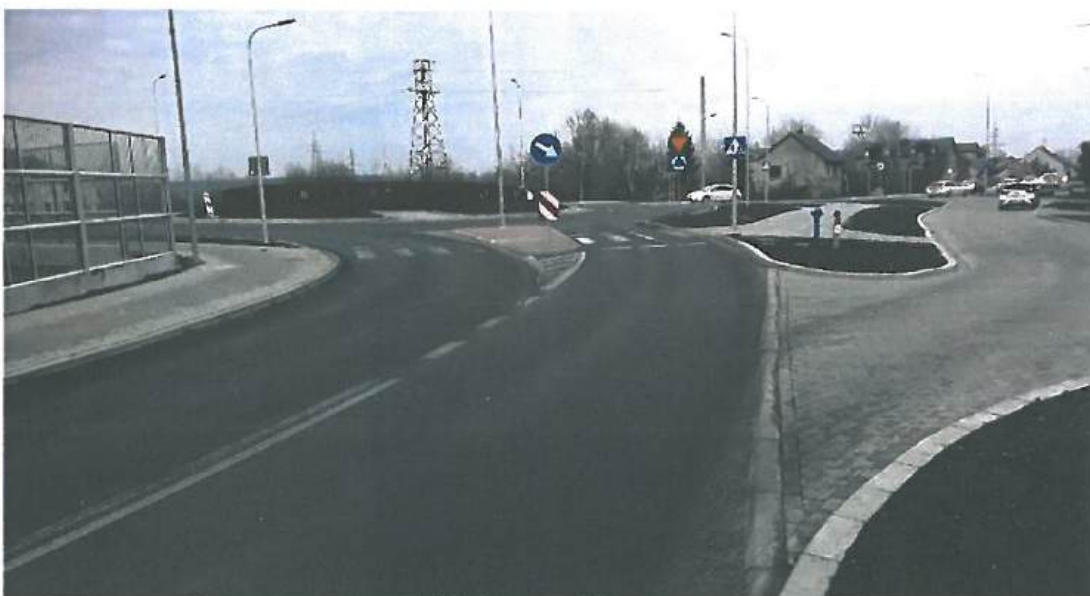
Fot. nr 5.2.2 Odcinek drogi powiatowej nr 1428K po rozbudowie skrzyżowania na ruch okrężny w miejscowości Bochnia
