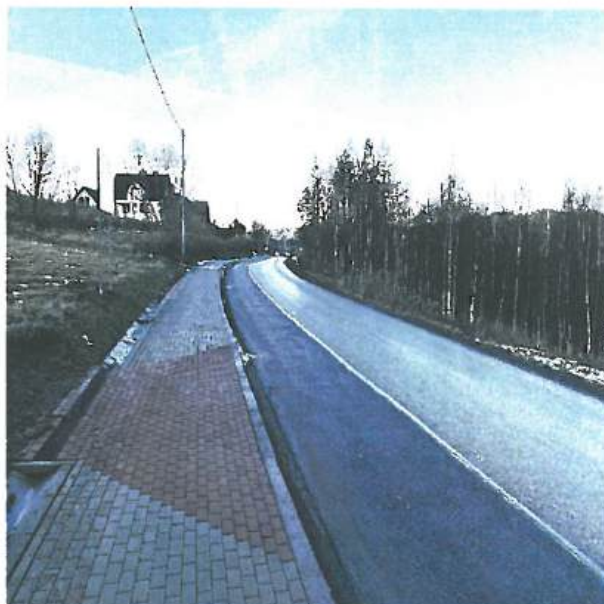
Fot. 5.9.2 Odcinek drogi powiatowej nr 2075K po rozbudowie drogi w miejscowości Żegocina
