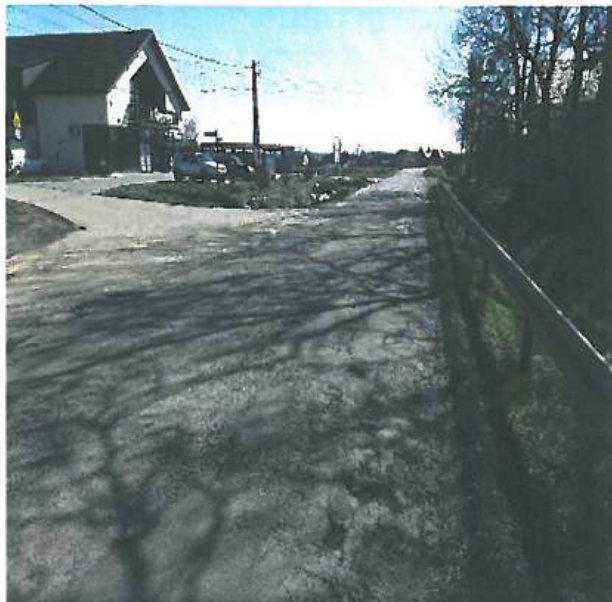
Fot. nr 5.5.1 Odcinek drogi powiatowej nr 1424K przed rozbudową drogi w miejscowości Słomka
