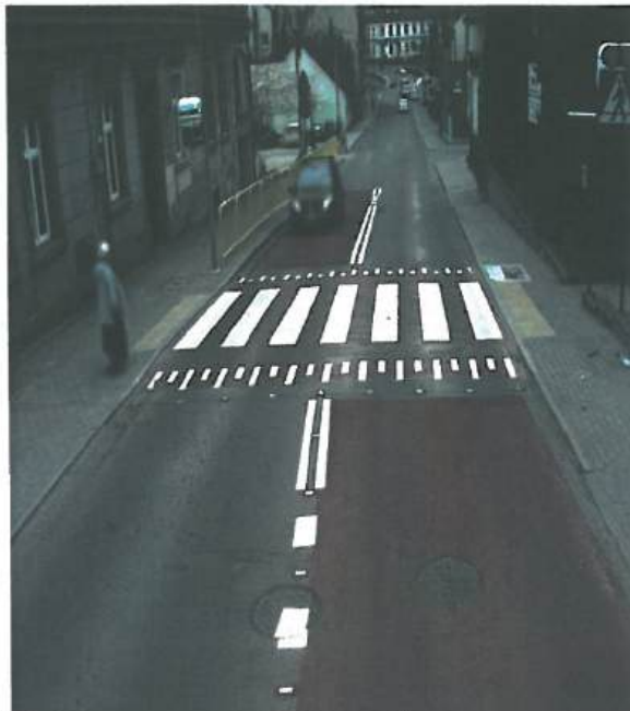
Fot.5.10.2 Odcinek drogi powiatowej nr 1443K po przebudowie drogi w miejscowości Bochnia
