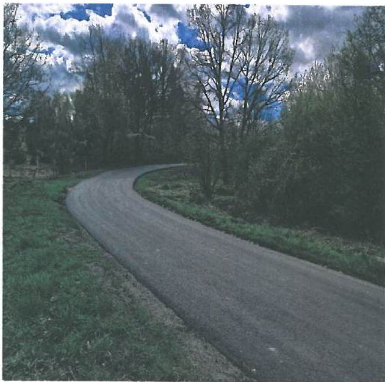
Fot. nr 10.4.2 Naprawa uszkodzonej nawierzchni DP nr 2081K w m. Leszczyna
