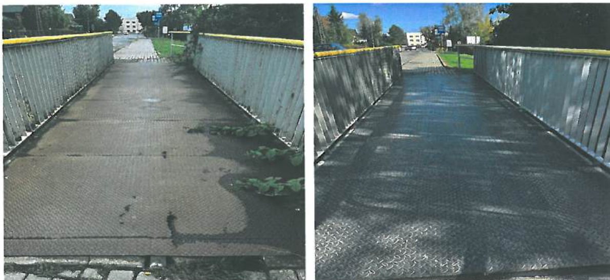
Fot. nr 10.9.1 Remont kładki dla pieszych w ciągu DP nr 1961K w miejscowości Łapanów
