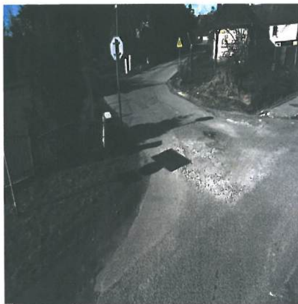
Fot. 5.8.1. Odcinek drogi powiatowej nr 1443K przed rozbudową drogi w miejscowości Bochnia
