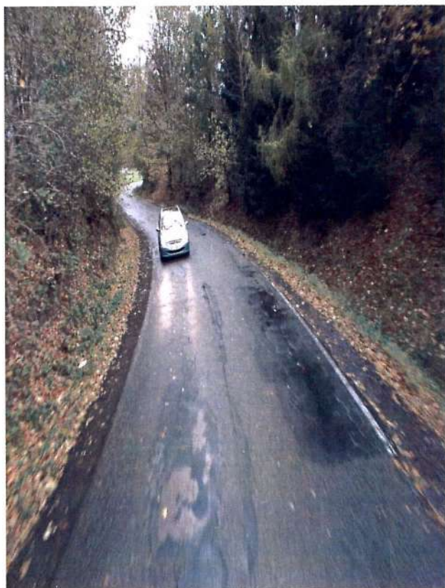
Fot. 5.1.11 Odcinek drogi powiatowej nr 1961K przed rozbudową drogi w miejscowości Kępanów
