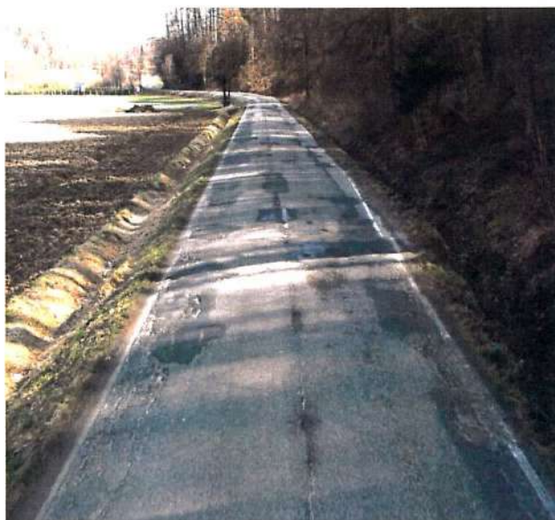
Fot.5.12.1 Odcinek DP nr 2083K przed przebudową drogi w miejscowości Wieruszycze
