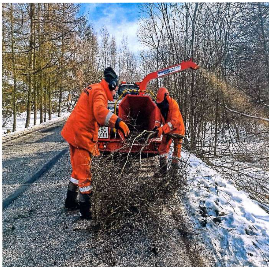
Fot.8.7.1 Prace porządkowe wykonywane przez pracowników PZD w Bochni
