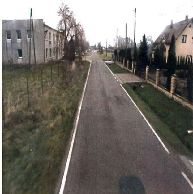
Fot. 5.6.1. Odcinek drogi powiatowej 2097K przed rozbudową drogi w miejscowości Drwinia
