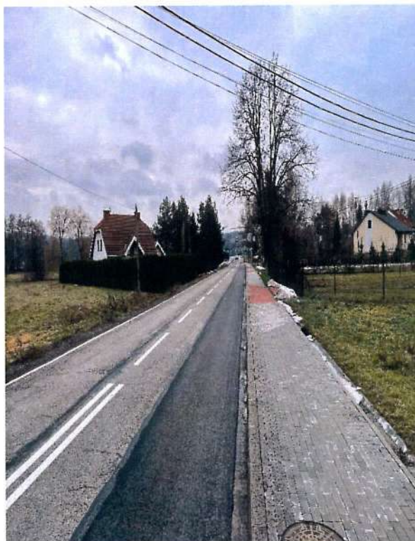
Fot. 5.7.2 Odcinek drogi powiatowej nr 2072K przebudowie drogi w miejscowości Rzezawa
