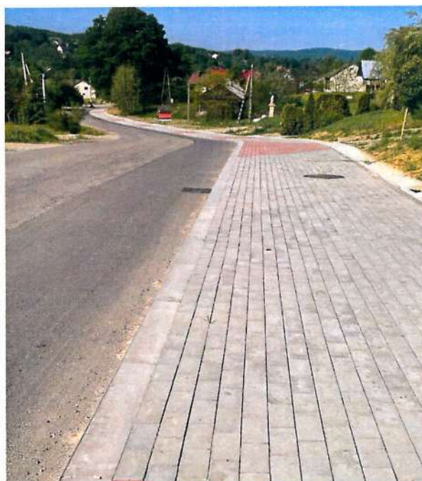
Fot. 5.5.2 Odcinek drogi powiatowej nr 1445K po wykonaniu rozbudowy drogi w miejscowości Lipnica Dolna
