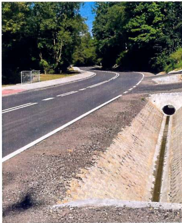
Fot. 5.4.2 Odcinek drogi powiatowej nr 2095K po rozbudowie w miejscowości Trzciana
