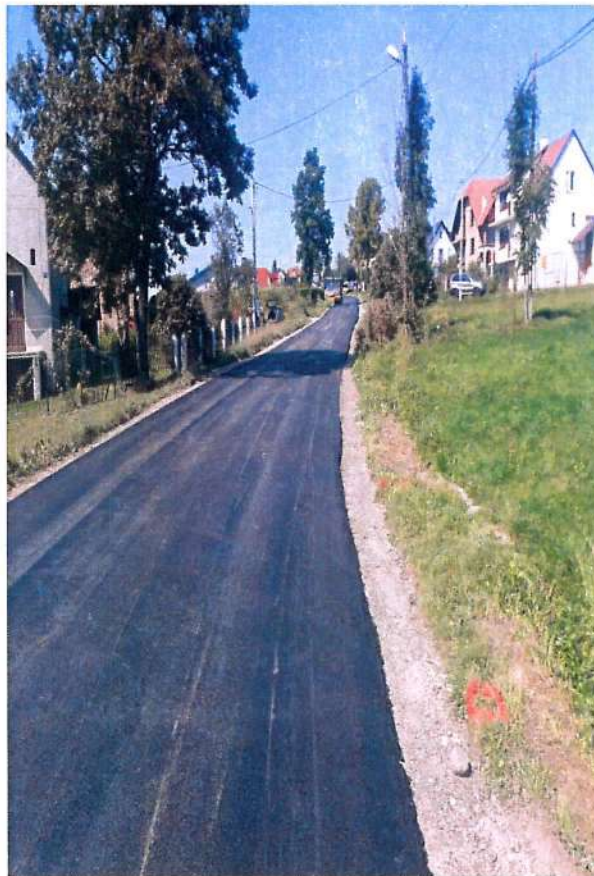
Fot.5.10.2 Odcinek DP nr 2080K w trakcie przebudowy drogi w miejscowości Wiśnicz Mały
