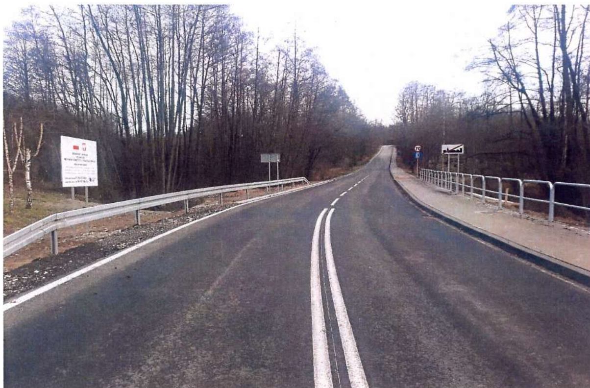
Fot. 5.1.2 Odcinek drogi powiatowej nr 2077K po rozbudowie w miejscowości Leksandrowa
