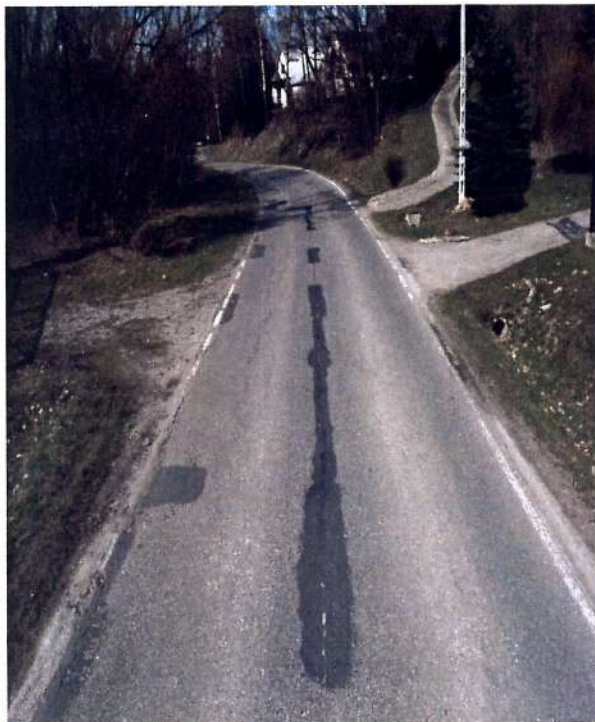
Fot. 5.4.1 Odcinek drogi powiatowej nr 2095K przed rozbudową w miejscowości Trzciana
