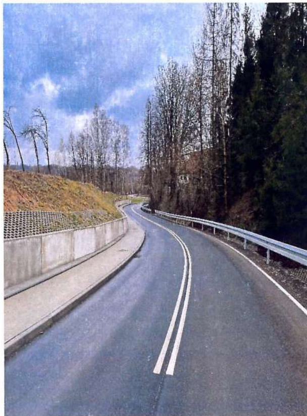
Fot. 5.1.12 Odcinek drogi powiatowej nr 1961K po rozbudowie drogi w miejscowości Kępanów
