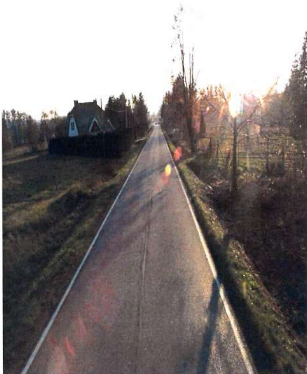
Fot. 5.7.1. Odcinek drogi powiatowej 2087K przed przebudową drogi w miejscowości Rzezawa
