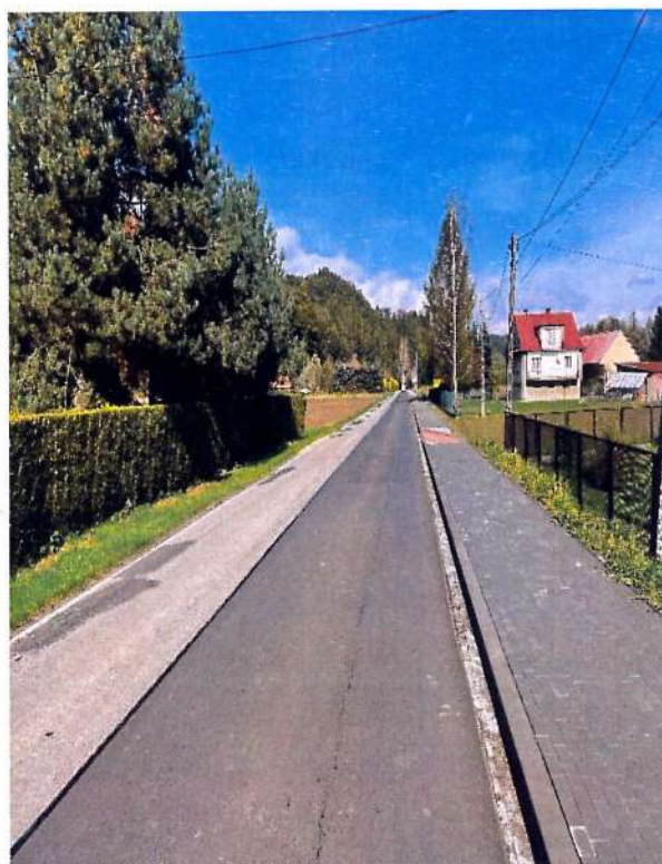
Fot. 5.1.10 Odcinek drogi powiatowej nr 2083K po rozbudowie drogi w miejscowości Kamyk
