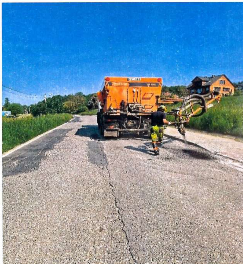
Fot. 8.2.1 Remonty cząstkowe nawierzchni bitumicznych mieszanką asfaltową z gryzami
