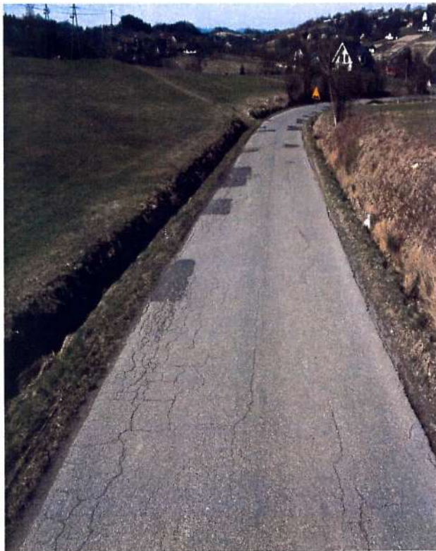
Fot. 5.1.7 Odcinek drogi powiatowej nr 2074K w trakcie realizacji rozbudowy drogi w miejscowości Żegocina
