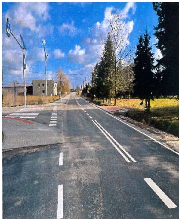
Fot. 5.6.2 Odcinek drogi powiatowej nr 2097K po rozbudowie drogi w miejscowości Drwinia
