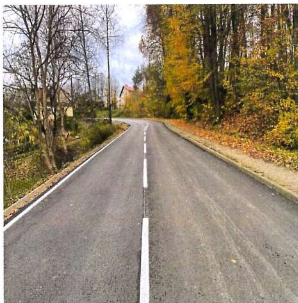
Fot. 5.11.2 Odcinek DP nr 1444K po wykonaniu przebudowy drogi w miejscowości Nowy Wiśnicz
