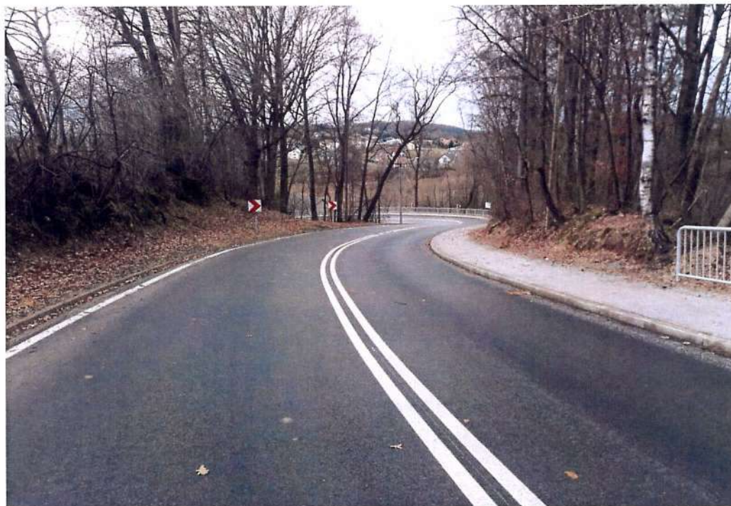
Fot. 5.3.2. Odcinek drogi powiatowej nr 1444K w miejscowości po rozbudowie drogi w miejscowości Nieszkowice Wielkie
