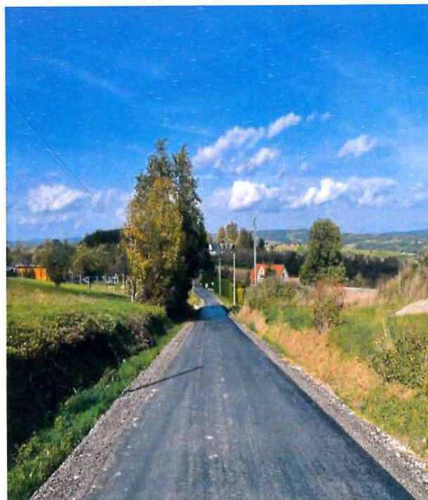
Fot. 5.9.2 Odcinek drogi powiatowej nr 2073K po drogi remoncie w miejscowości Zbydniów
