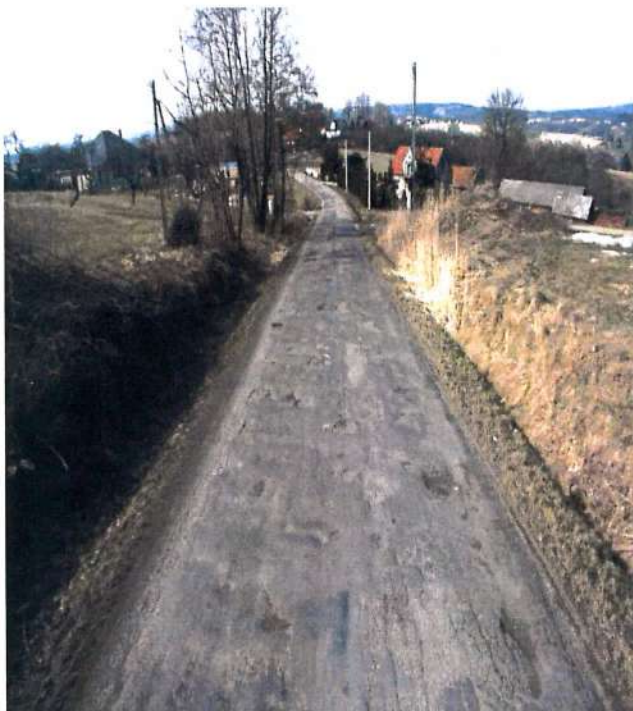
Fot. 5.9.1 Odcinek drogi powiatowej nr 2073K przed remontem drogi w miejscowości Zbydniów
