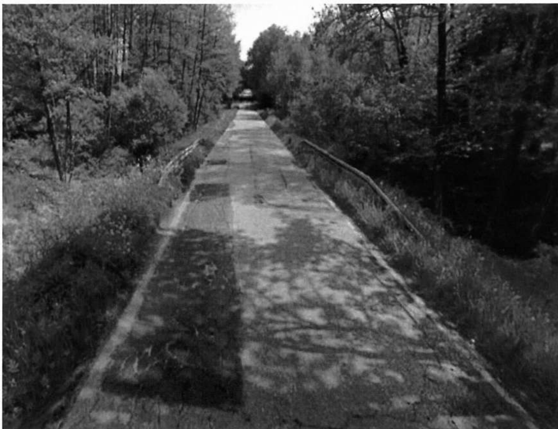
Fot. 5.1.1 Odcinek drogi powiatowej nr 2077K przed rozbudową drogi w miejscowości Leksandrowa
