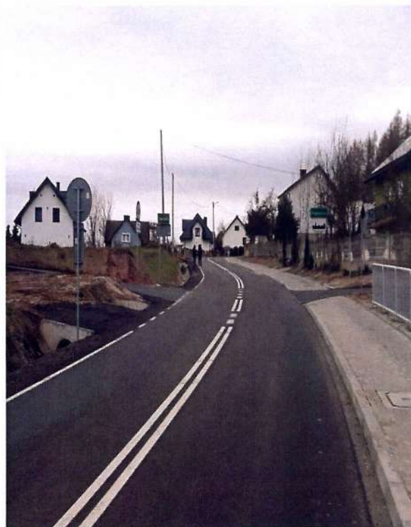
Fot. 5.2.2 Odcinek drogi powiatowej nr 2085K po rozbudowie drogi w miejscowości Zawada
