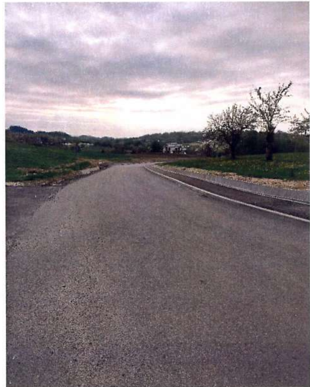
Fot. 5.1.8 Odcinek drogi powiatowej nr 2074K po wykonaniu rozbudowy drogi w miejscowości Żegocina
