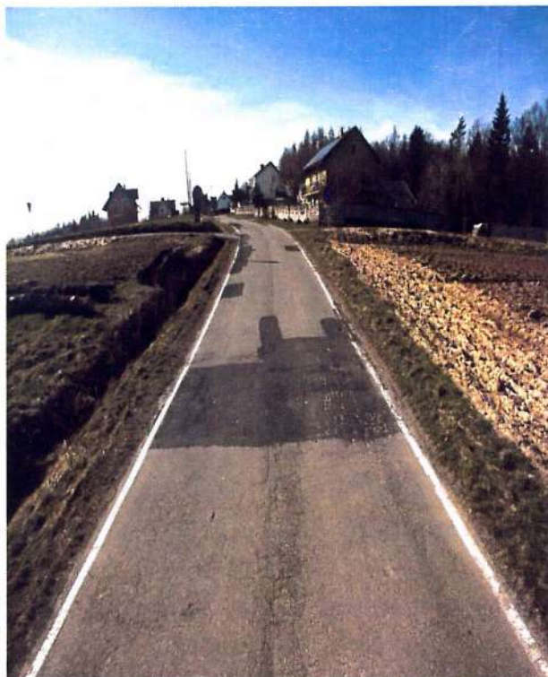
Fot. 5.2.1 Odcinek drogi powiatowej nr 2085K przed rozbudową drogi w miejscowości Zawada
