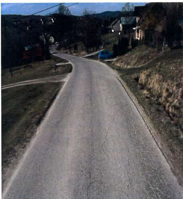
Fot. 5.5.1 Odcinek drogi powiatowej nr 1445K przed rozbudową drogi w miejscowości Lipnica Dolna
