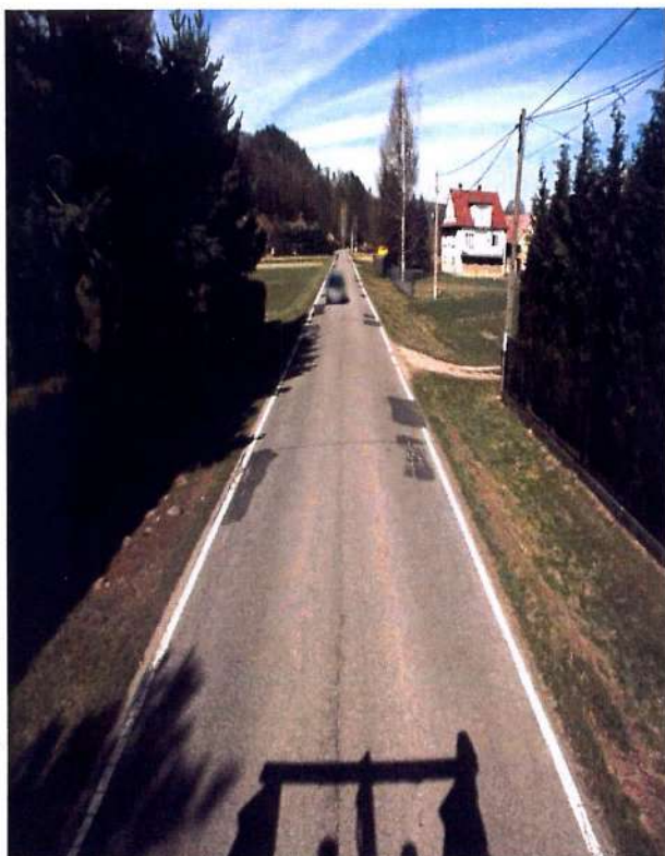
Fot. 5.1.9 Odcinek drogi powiatowej nr 2083K przed rozbudową drogi w miejscowości Kamyk
