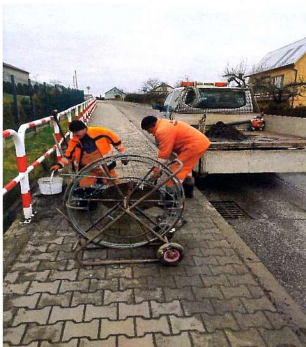
Fot.8.7.2 Prace porządkowe wykonywane przez pracowników PZD w Bochni
