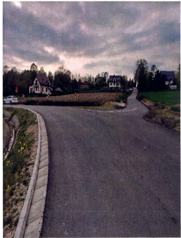
Fot. 5.1.6 Odcinek drogi powiatowej nr 2074K po wykonaniu rozbudowy w miejscowości Beldno
