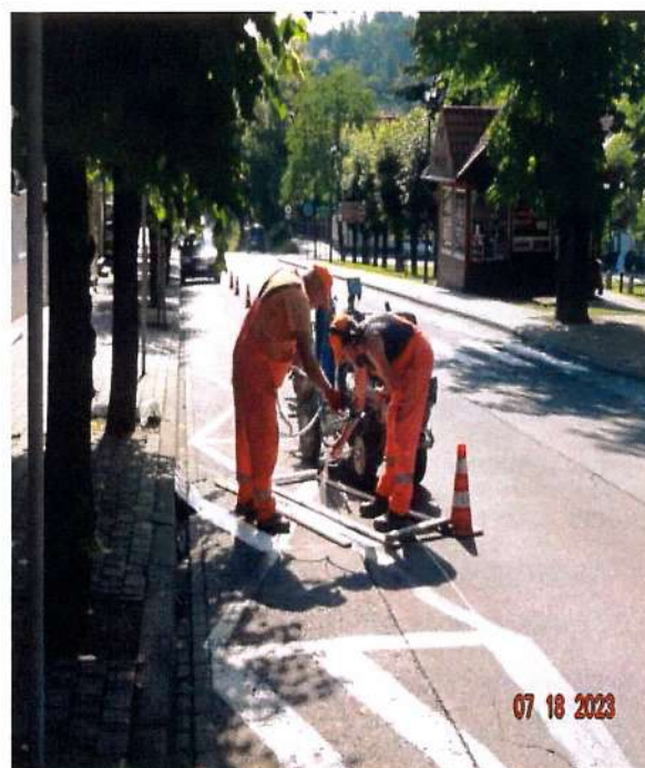
Fot. 8.7.3 Malowanie oznakowania poziomego
